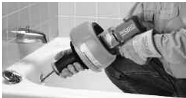
Рис. 9 – Протолкните трос дальше в канализационную трубу
