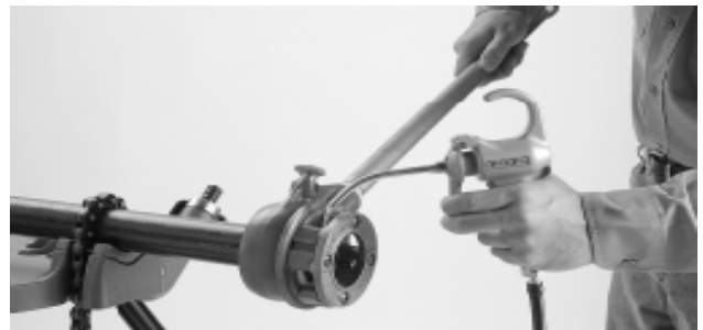
Рис. 4 – Нанесение масла на трубу
