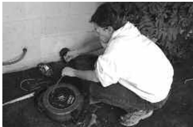
Рис. 21 – Пользование проталкивающим кабелем microReel
