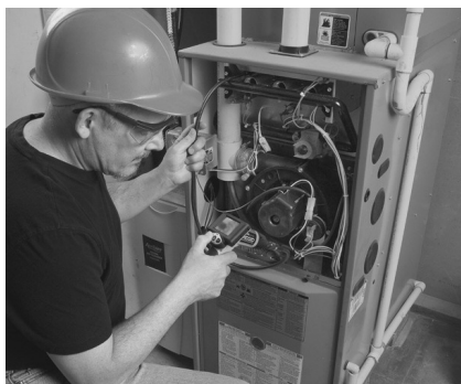
Рисунок 1 – Осмотр системы отопления, вентиляции и кондиционирования воздуха
